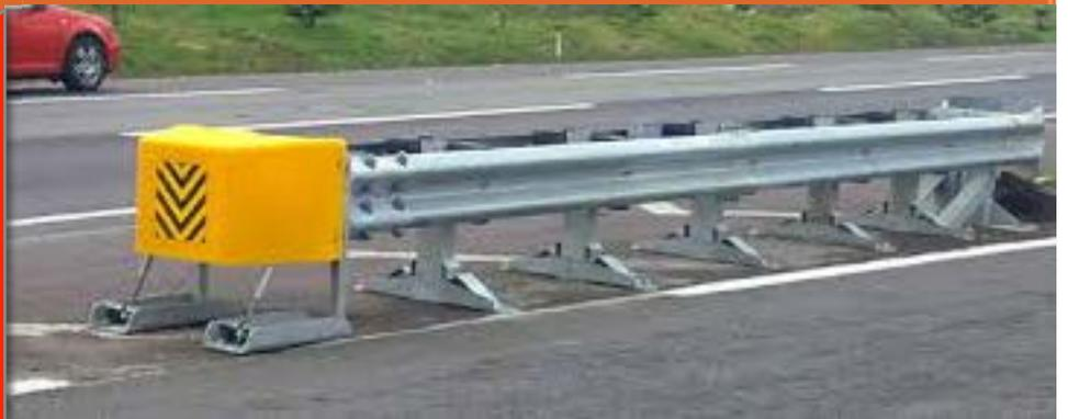
La generación de amortiguadores híbridos de Trinity, fabricados con materiales metálicos y plásticos proveen una gran resistencia a los impactos frecuentes, requieren de menor mantenimiento y ofrecen un mayor tiempo de servicio. Disponibles en diferentes modelos y configuraciones, son ideales para proteger puntos de impactos recurrentes y cuentan con la certificación del Reporte 350 de la NCHRP.
